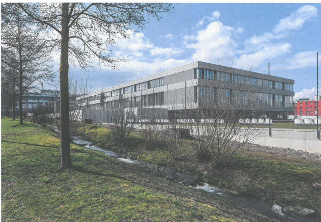
Die Fassade des Schulhauses Blumenfeld in Zürich-Affoltern ist nüchtern, abgesehen von Einlagen aus Naturstein.
